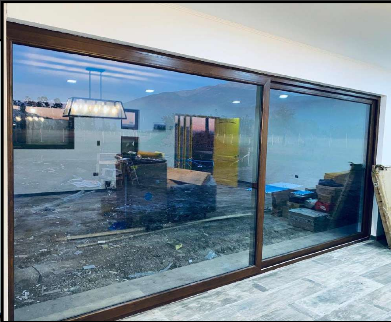
VENTANALES Cristal termopaneles en perfil PVC color nogal.
